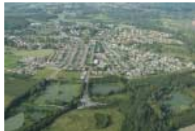
Un ensemble de cités témoins des évolutions dans la construction (ex. Cités Lemay Sainte Marie et Nouvelle à Pecquencourt)
