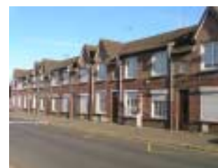
Le logement en barre simple
