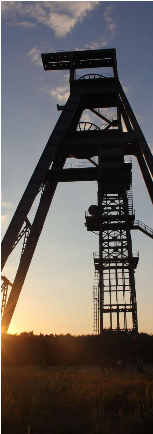
Chevalement Ledoux, Condé-sur-l'Escaut ©Mission Bassin Minier
