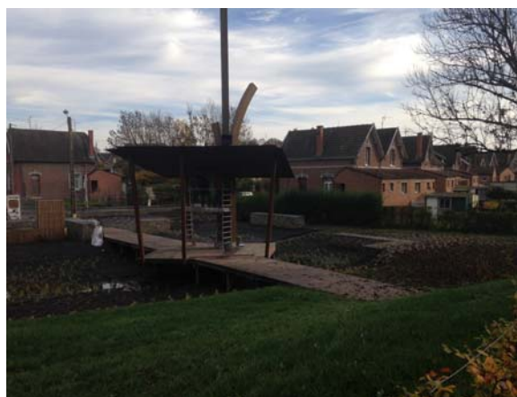
Avant et après travaux : Cité Taffin, un bassin de tamponnement paysager recueillant les eaux de pluies provenant des noues a été aménagé.
