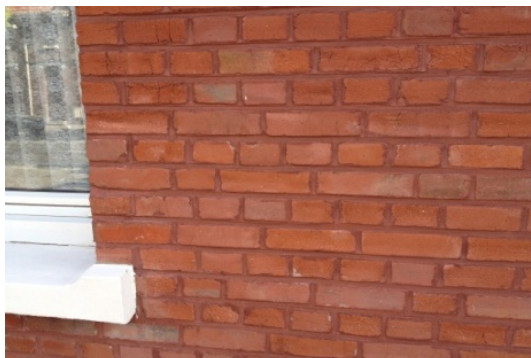
Rénovation « UNESCO » : hydrogommage, couleur des joints adaptés au ton de la brique et « tirés au fer »
