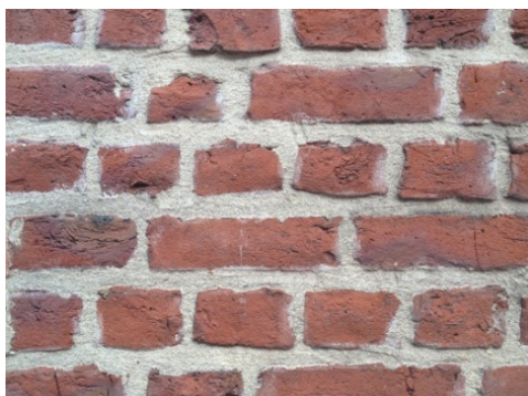
Rénovation « classique » : sablage et joints claires beurrés
