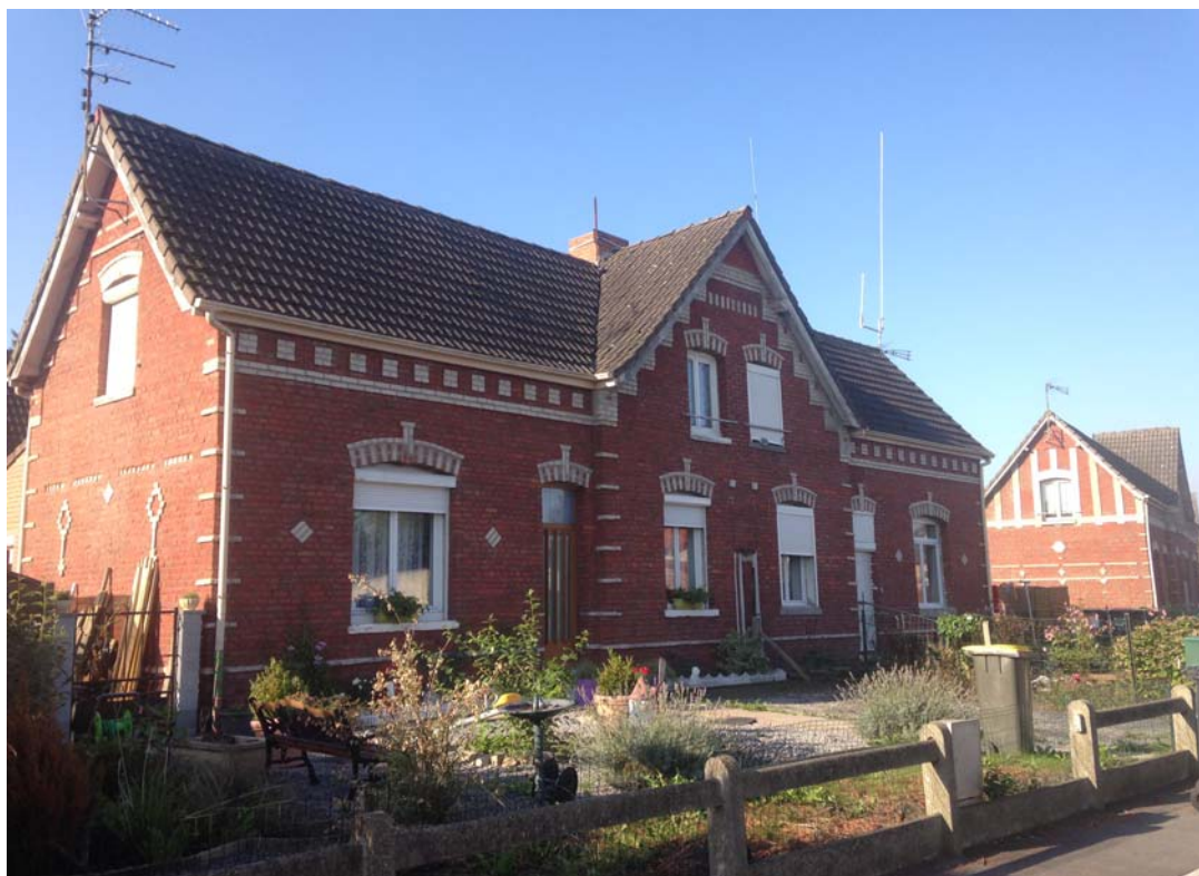
Rénovation d'une façade sur la cité Lemay
