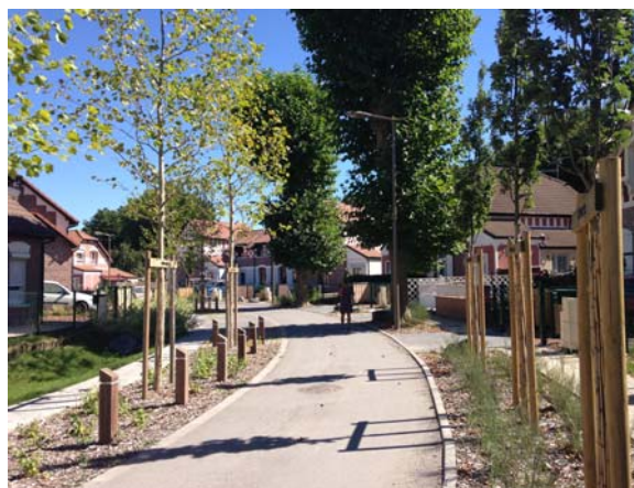
Avant et après travaux : Cité Bruno, l'ensemble des voies ont été profilées pour mettre en place un système de noues assurant une infiltration des eaux de pluie. Cette technique dite de traitement alternatif des eaux de pluie a été mise en œuvre également cité Taffin et cité des électriciens. Dans les cité Lemay et Sainte Marie et cité Thiers, l'état des réseaux déjà existants ne justifiaient pas (au regard de l'enveloppe financière globale) de modifier le système en place.
